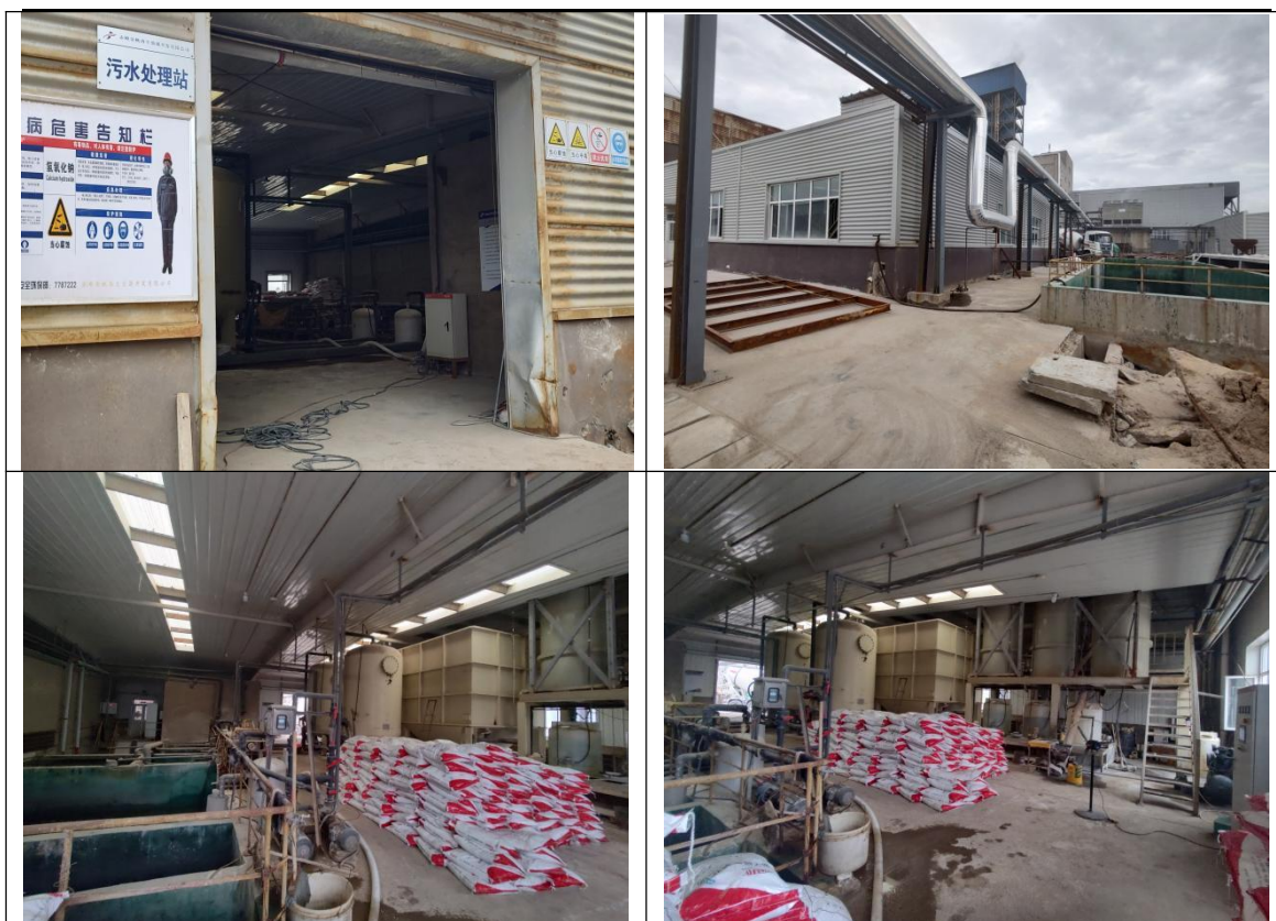
附图一：污水处理站现状照片
